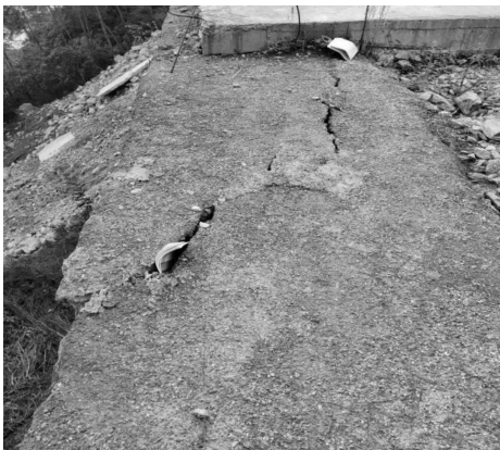
图 5 水平裂缝 L03 扭错 1.0~4.0 cm
