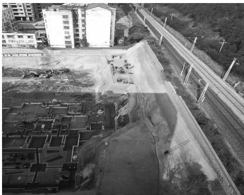
图 2 临近铁路路基照片
