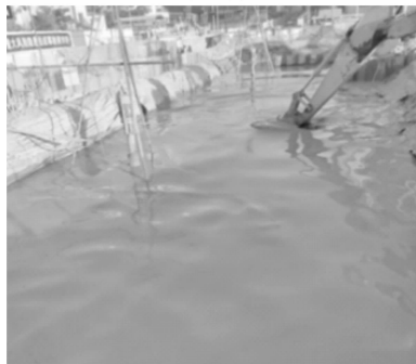
(b) 现场泥浆搅拌调配
