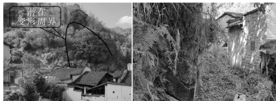
(a) 滑坡变形周界 (b) 坡角与民房位置
